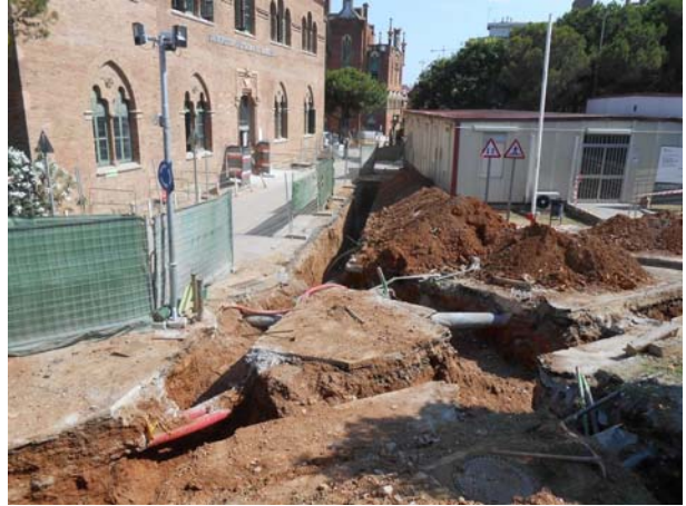
Foto 8. Rases en Camp de Captació 1, Zona A2
