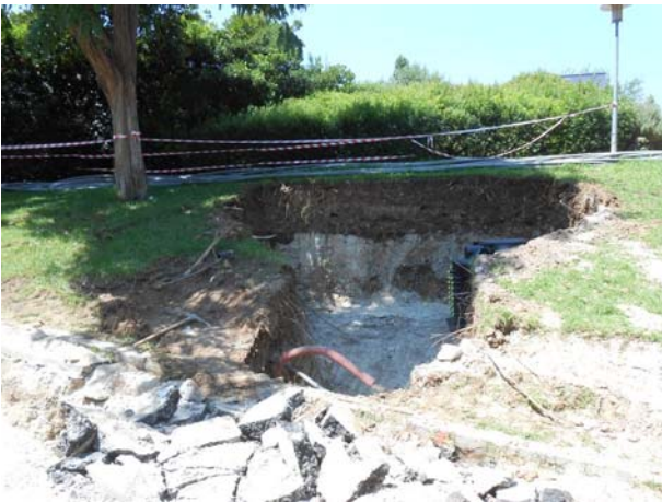
Foto 13. Fossat per arqueta en zona A1
