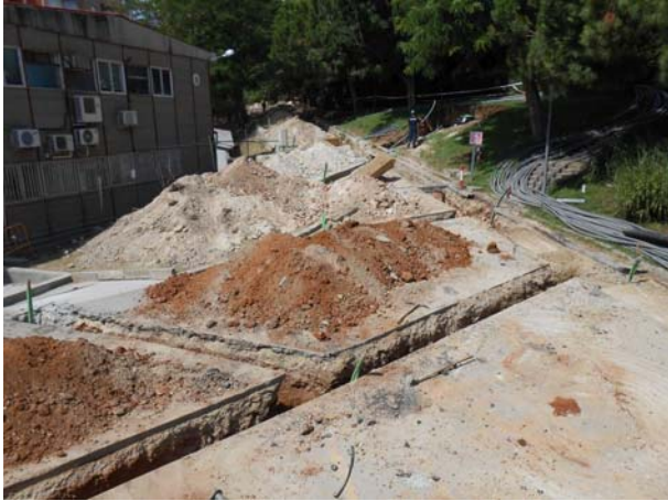
Foto 7. Rases en camp de captació 1. Zona A1
