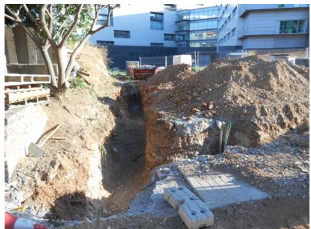
Foto 10. Rases en camp de captació 2. Zona B2
